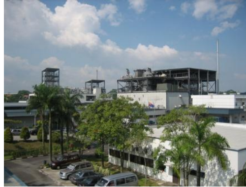
リケビタ・マレーシア外観
