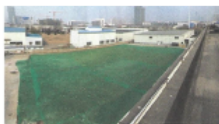
◀新工場 建設予定地
