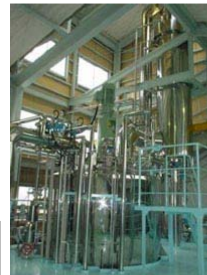
大阪工場蒸留設備
